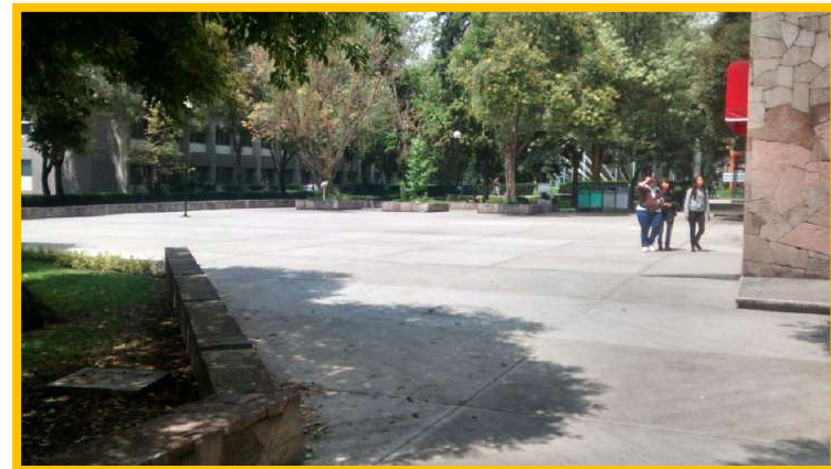
A3 1er. y 2do. Piso Escaleras de Concreto
