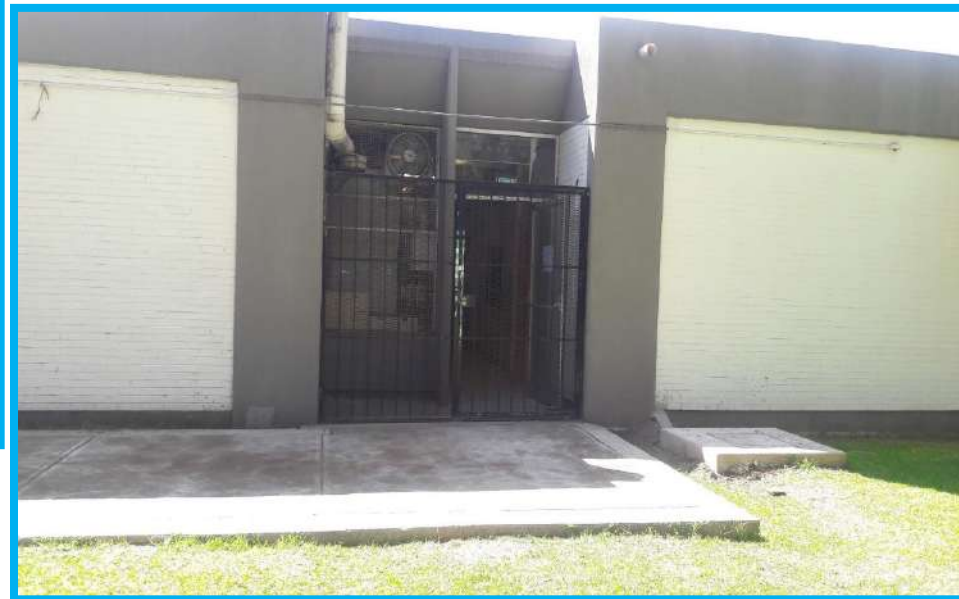
UMF Salida de Emergencia
