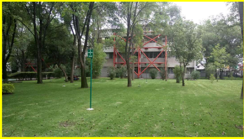
PB, 1er. y 2do. Piso Escalera de Emergencia
