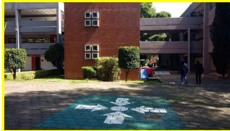
PB, 1er. y 2do. Piso Escalera de Concreto
