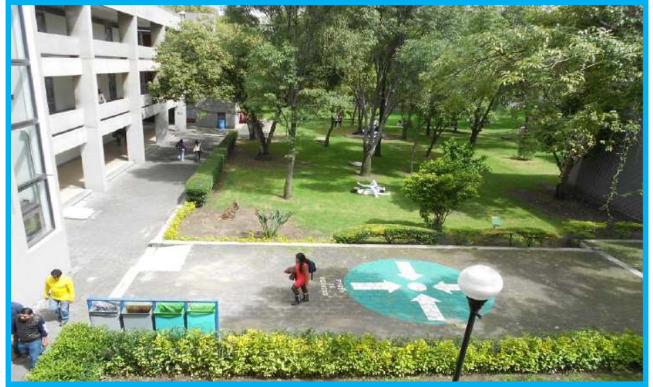
-Planta Baja A5 -1er. y 2do. Piso Área Verde (Escalera de Concreto)
